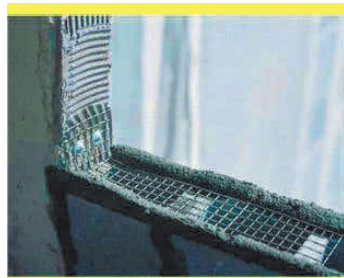
Figura 1: Fixação de alvenaria com tela eletro soldada.
