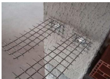
• Figura 6 – Telas metálicas interface estrutura x alvenaria
