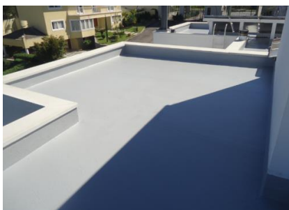
• Figura 7 – Exemplo de laje impermeabilizada
