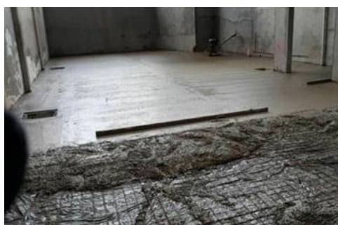
• Figura 26 – Exemplo de concretagem do contrapiso
