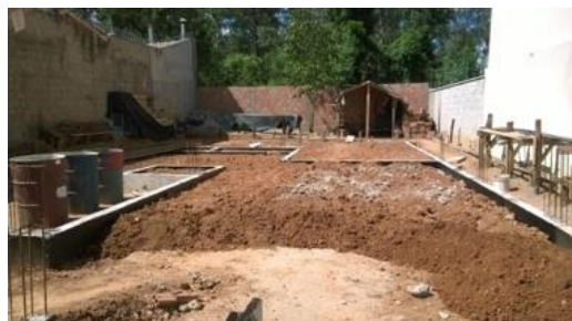
• Figura 24 – Exemplo de preenchimento e compactação do solo
