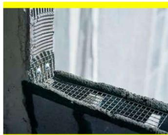
*Figura 1: Fixação de alvenaria com tela eletro soldada.*
