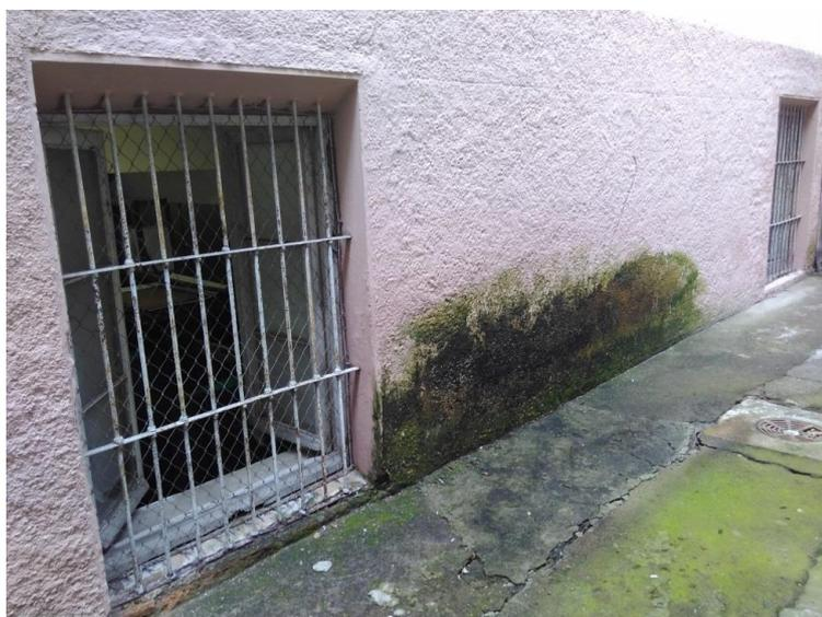
Figura 118 - Intensa umidade com infiltrações. Fonte dos autores.
