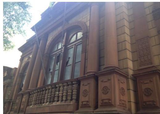
Figura 12 - Vidros quebrados. Fonte: GAÚCHA
