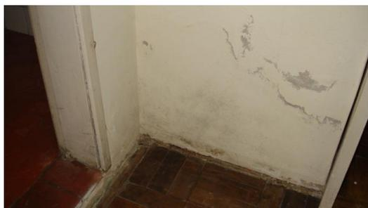
Figura 109 - Umidade. Fonte dos autores.
