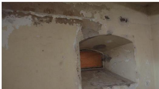
Figura 106 - Janela sem proteção aos micro-organismos. Fonte dos autores.
