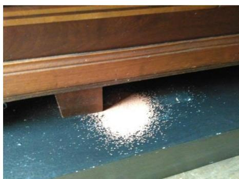
Figura 65 - Detalhe da ação de cupins. Fonte dos autores.
