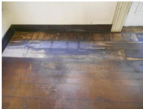
Figura 39 - Piso danificado pela chuva. Fonte dos autores.
