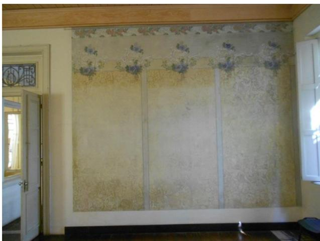
Figura 40 - Parede afetada pela intensa luz solar. Fonte dos autores.
