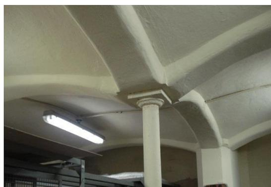
Figura 104 - Teto em abóboda. Fonte dos autores
