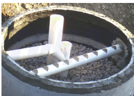
FILTRO ANAERÓBICO
