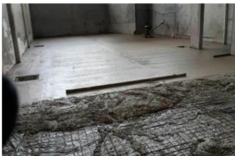
• Figura 26 – Exemplo de concretagem do contrapiso
