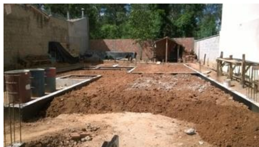
• Figura 24 – Exemplo de preenchimento e compactação do solo
