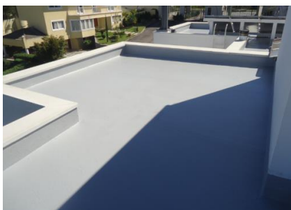
• Figura 7 – Exemplo de laje impermeabilizada
