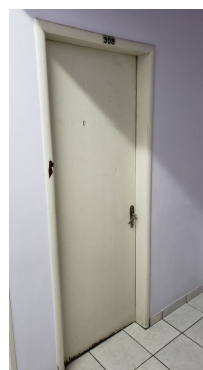
Porta de acesso ao imóvel avaliando
