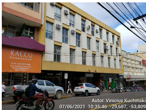
Vista geral do edifício
