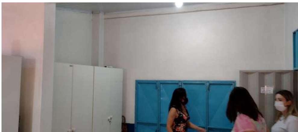
Foto 15: Cozinha com pé direito baixo, em torno de 2,00m, local com ventilação e iluminação natural precária.
