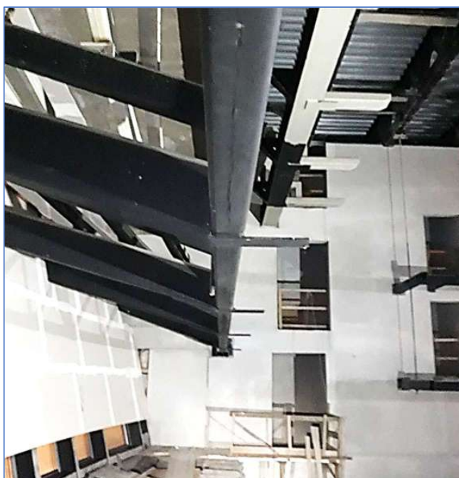
Figura 4: estrutura do mezanino já montada.
