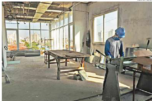
Prédio terá sete pavimentos e ligação interna com Hospital Conceição
