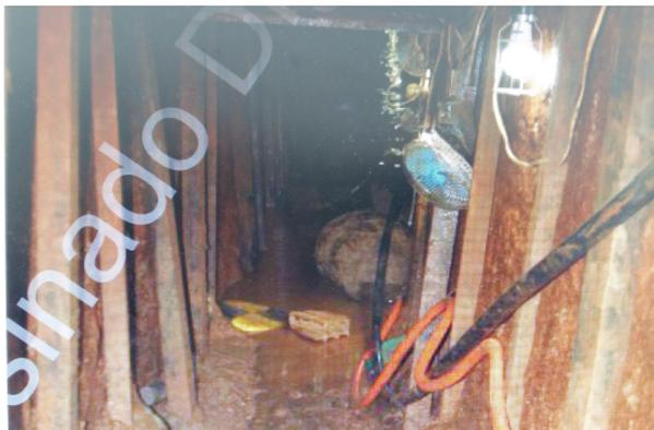
Conforme pode ser observado, o calçamento estrutural do túnel foi feito com pontaletes e pranchões de madeira, com espaçamento variando de 0,70m a 1,10m.
