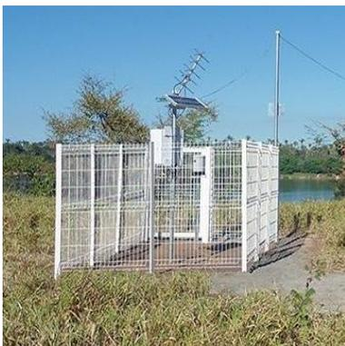
**Figura 16: Instalação de PCD em um poste baixo e cercado por grade**
